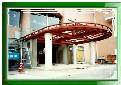
正面玄関の庇（工事中）
